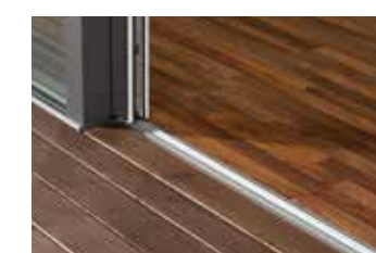
Stufenloser Übergang und nahtloser Anschluss des Terrassenbodens
