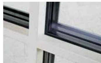
K25-H 25 mm breit mit Glassteg auch ohne Glassteg möglich
