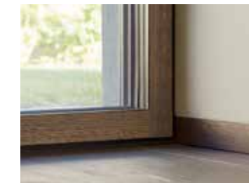
Sockelleiste mit flächenbündigem Wandabschluss
