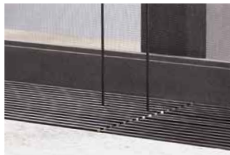
Verdeckte Seilabspannung bei Entwässerungsschacht
