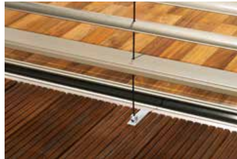
Verdeckte Seilabspannung bei FixFrame Platin fest unter dem Boden verankert
