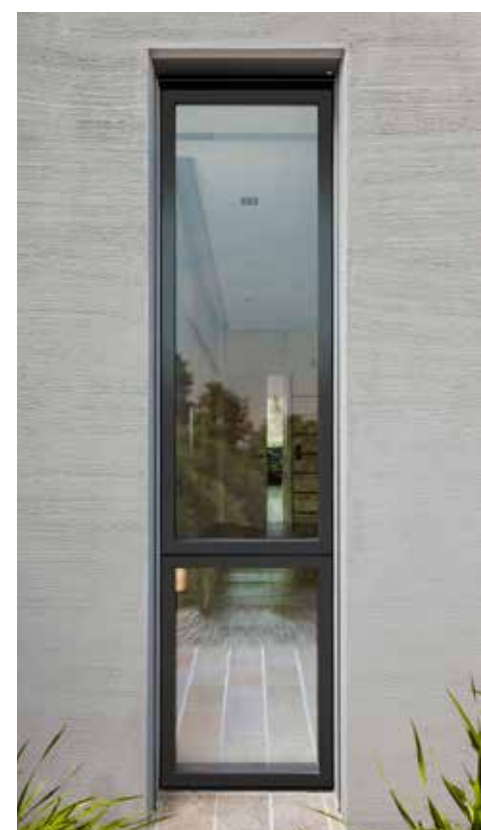
Insektenschutzgitter-ONE Spannrahmen vor dem oberen öffnbaren Fenster: kaum zu sehen.
